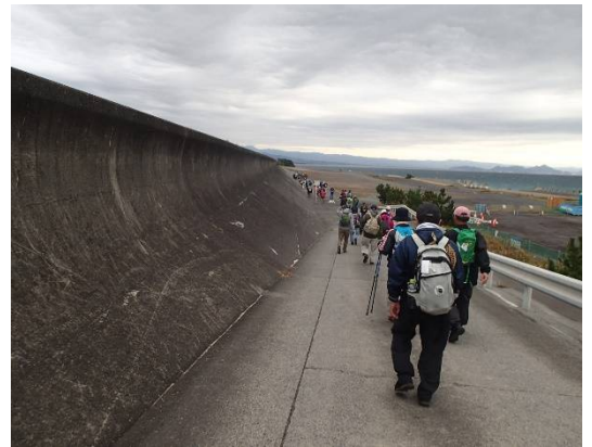
巨大な防潮堤で海岸線を完全に遮断されている
